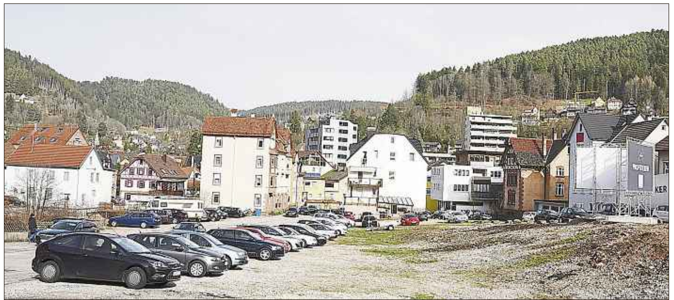
Rings um das Haas-Areal, auf dem das medizinische Versorgungszentrum entstehen soll, werden die Straßen saniert. Foto: Wegner
